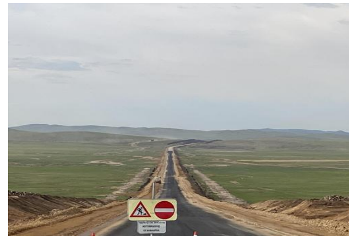
Өндөрхаан-Норовлин чиглэлийн 130 км хатуу хучилттай авто замын багц-1 буюу 68.6 км замын 2 дахь хэсгийн хучилт хийгдсэн байгаа нь.
