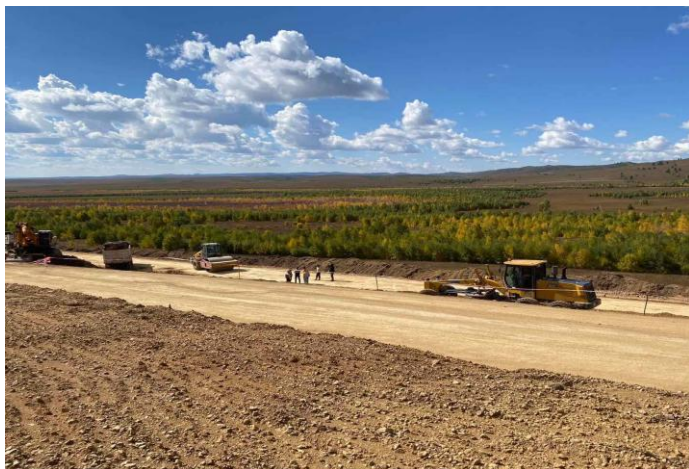
Баян-Уул-Ульхан боомт чиглэлийн 50 км авто замын газар шорооны ажил хийгдэж байна.
