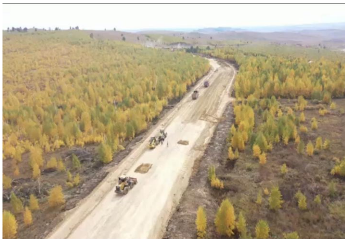
Баян-Уул-Ульхан боомт чиглэлийн 50 км авто замын газар шорооны ажил хийгдэж байна.
