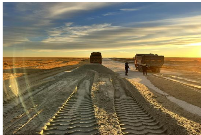
Хэрлэн сумаас Хавиргын боомт чиглэлийн 124.5 км авто замын газар шорооны ажил хийгдэж байна.
